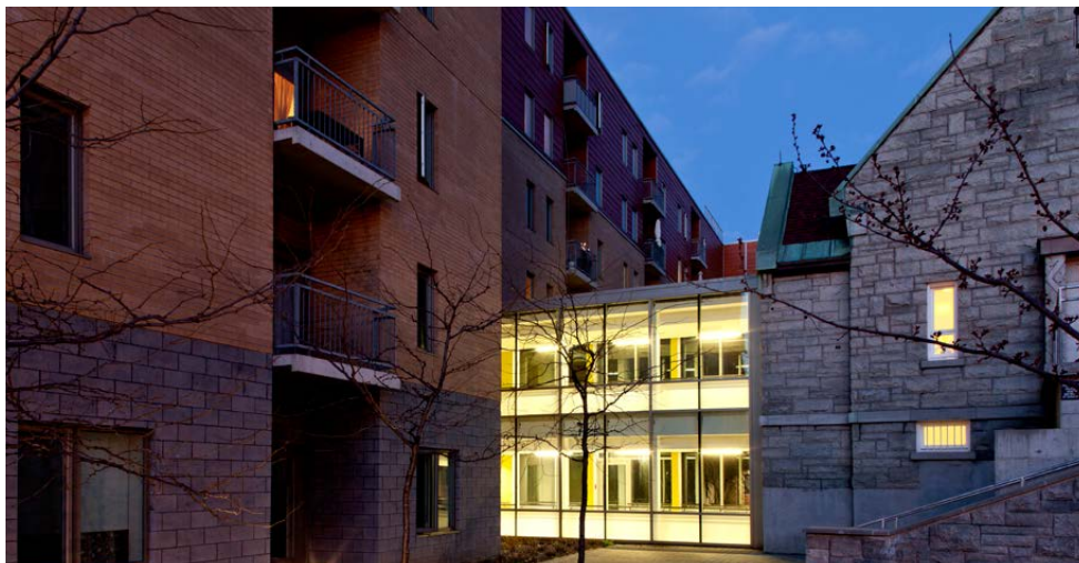
GRÂCE À L'USAGE ABONDANT DU VERRE, LES PASSERELLES N'ALTÈRENT PAS LES VUES SUR L'ÉGLISE. Photo : Normand Rajotte
