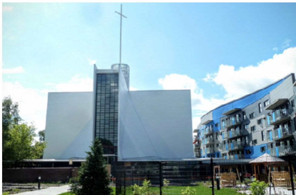
LES NOUVELLES INSTALLATIONS DU SITE SAINTE-GERMAINE-COUSIN ONT ÉTÉ JUDICIEUSEMENT IMPLANTÉES AFIN DE LAISSER LA PLEINE VISIBILITÉ À L'ANCIENNE ÉGLISE.
