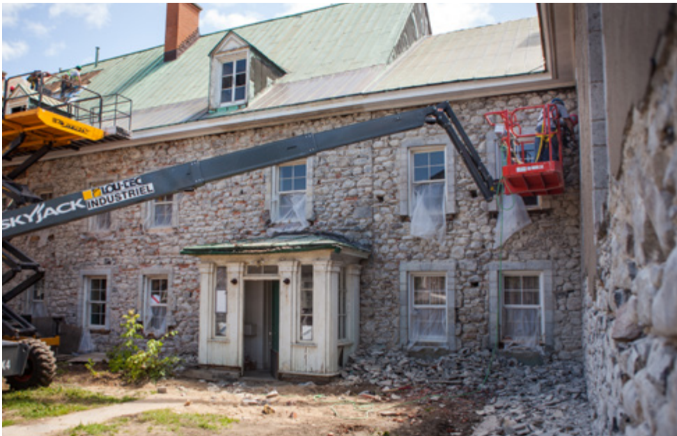
TRAVAUX DE RESTAURATION DE L'ENVELOPPE EXTÉRIÈRE.
