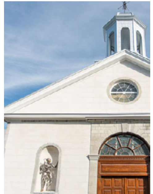
NOUVEAU REVÊTEMENT EXTÉRIEUR ET ŒUVRES D'ANNIE PELLETIER.
